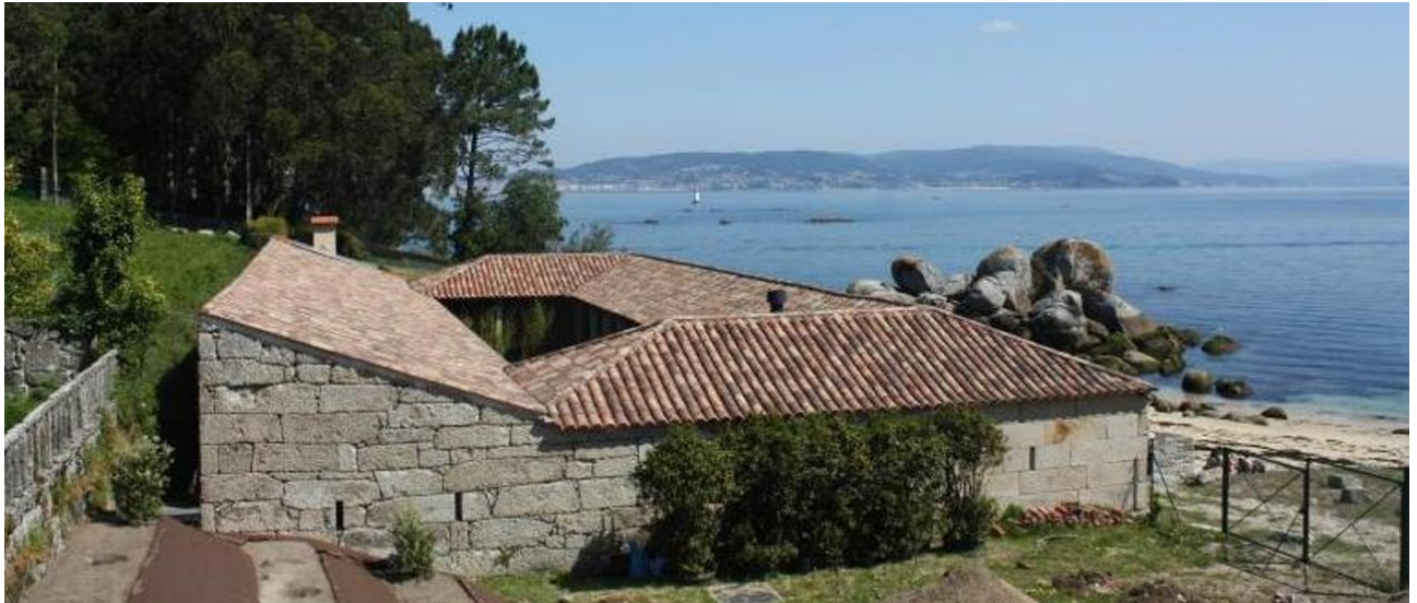
Una vista exterior de la salazón de Mourisca, en Beluso.
