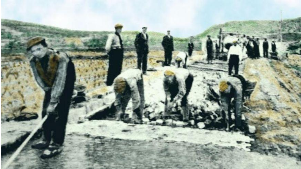
Os traballos de construción dunha estrada en 1926, con máis xente mirando que traballadores.
