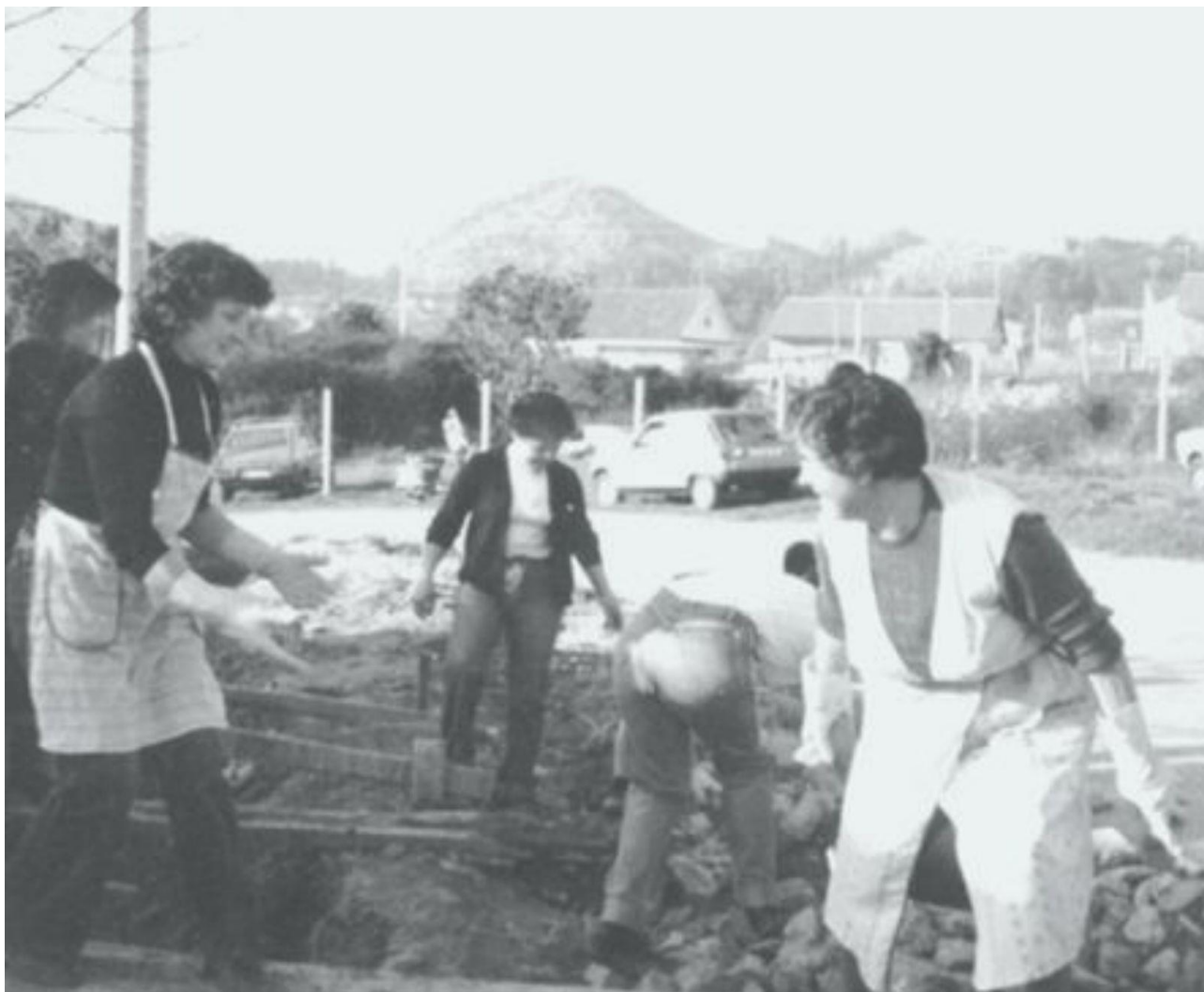
Nais que construían as gradas do patio do colexio. Arquivo Xerardo Dasairas
